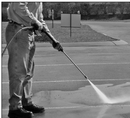
Figura 11 - Mejor ángulo de limpieza de superficies
