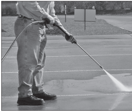
Figura 12 - Mejor ángulo de limpieza de superficies
