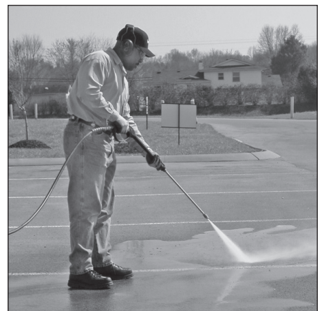
Figure 19 - Angle optimal de nettoyage de la surface
