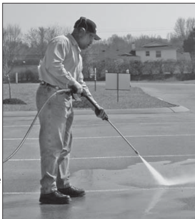
Figure 16 - Angle optimum par rapport à la surface à nettoyer
