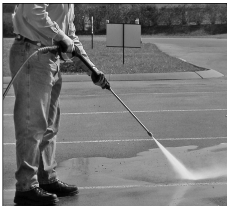
Figura 12 - Mejor ángulo de limpieza de superficies
