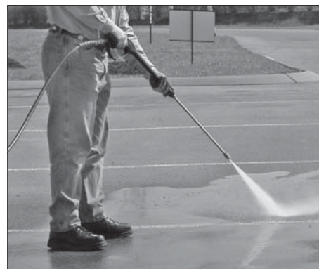
Figura 22 - Ángulo mejor para limpiar una superficie
