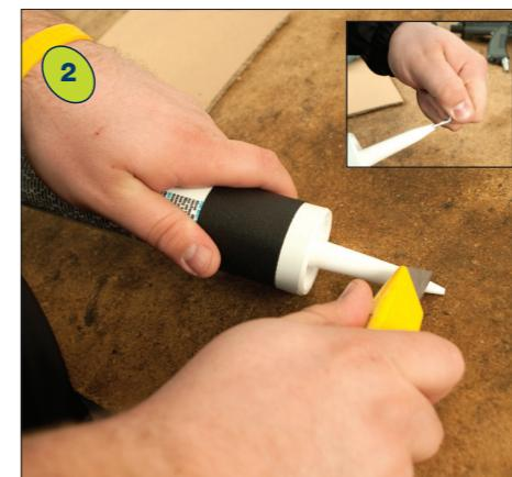
Préparez le tube de mastic. Lisez les directives sur le tube avant de couper le bout et briser le sceau. Coupez le bout avec le couteau rasoir à un angle de 45 degrés. REMARQUE : Pour un boudin étroit, coupez le bout. Pour un boudin plus large, coupez plus loin du bout. Utilisez un long clou pour briser le sceau. Insérez le tube de mastic dans le pistolet.
