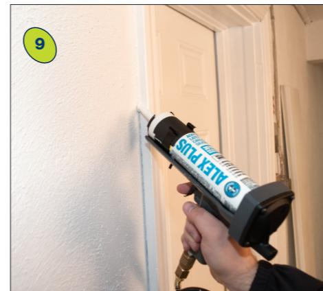
Commencez dans un coin ou joint sur la surface de travail. Placez un long boudin uniforme et continu. Evitez une série de boudins courts. Tenez le pistolet de calfeutrage à une position qui force le matériel dans les joints et les fentes.
