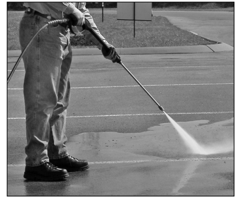
Figura 14 - Ángulo mejor para limpiar una superficie
