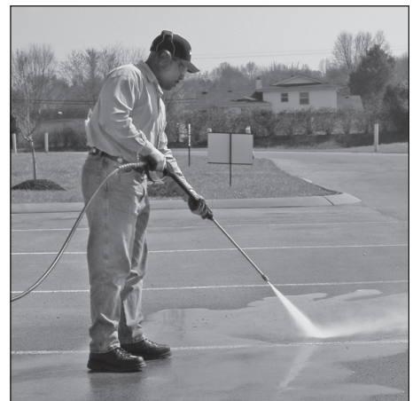
Figura 15 - Ángulo óptimo para la limpieza de la superficie
