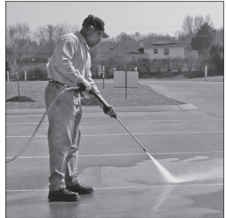
Figure 15 - Angle optimum par rapport à la surface à nettoyer
