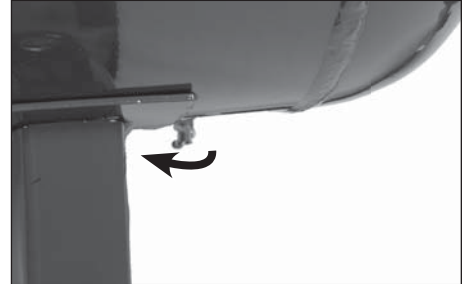
Figura 10 - Drenaje manual del tanque
